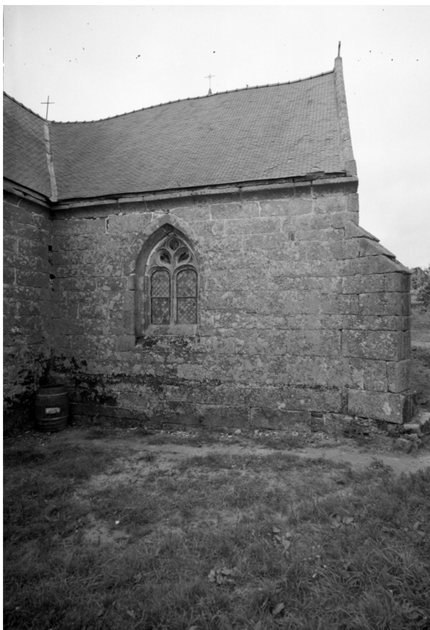
Croisillon nord : élévation est
