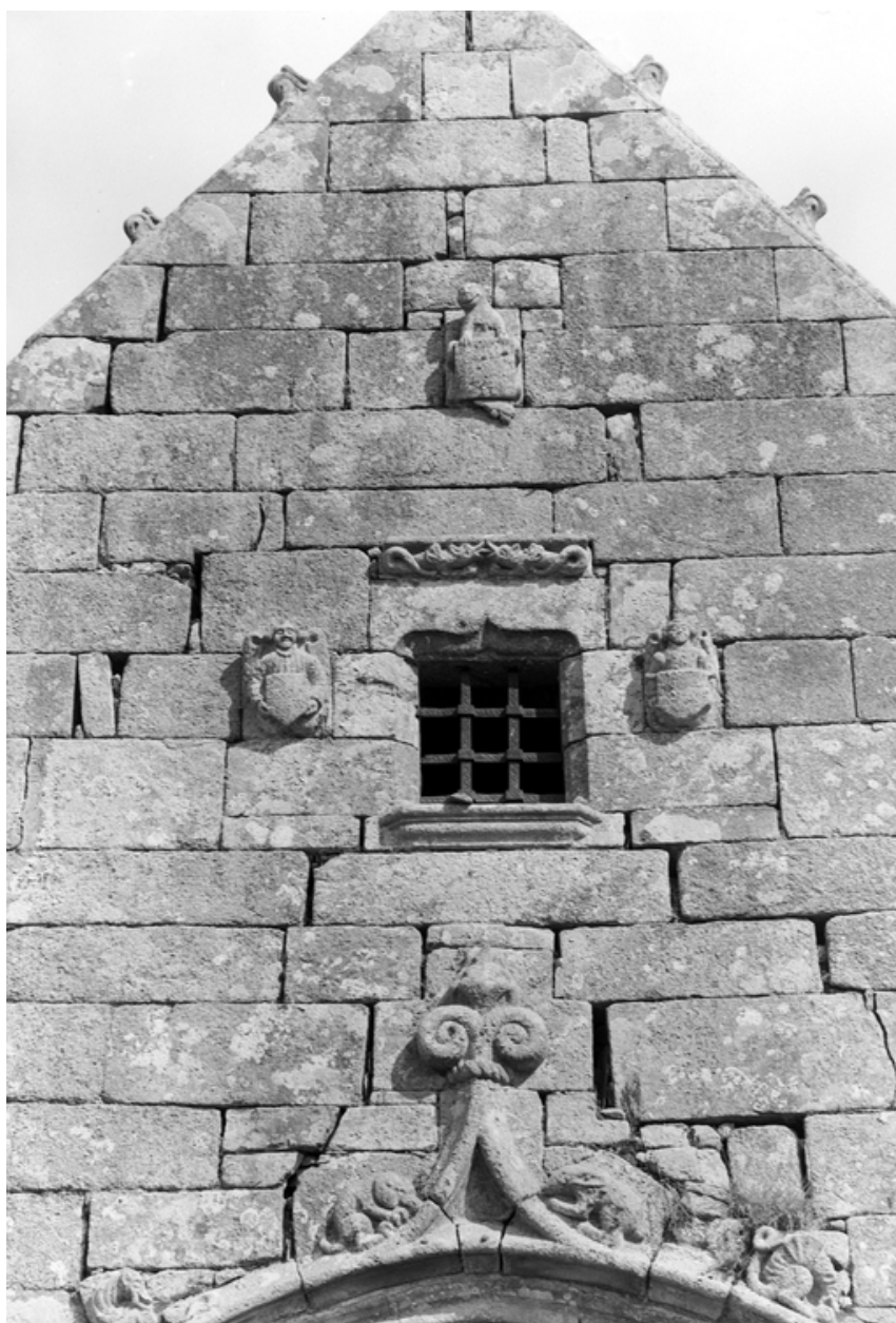
Pignon du porche, détail : fenêtre et reliefs du pignon
