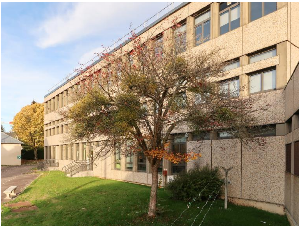
Bâtiment B (externat et foyer), façade arrière.
