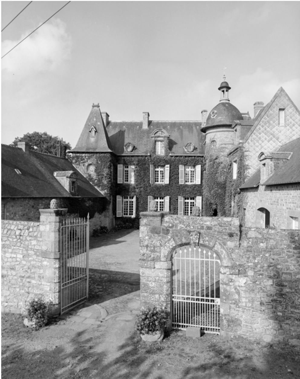
Elévation sud, vue générale sud.
