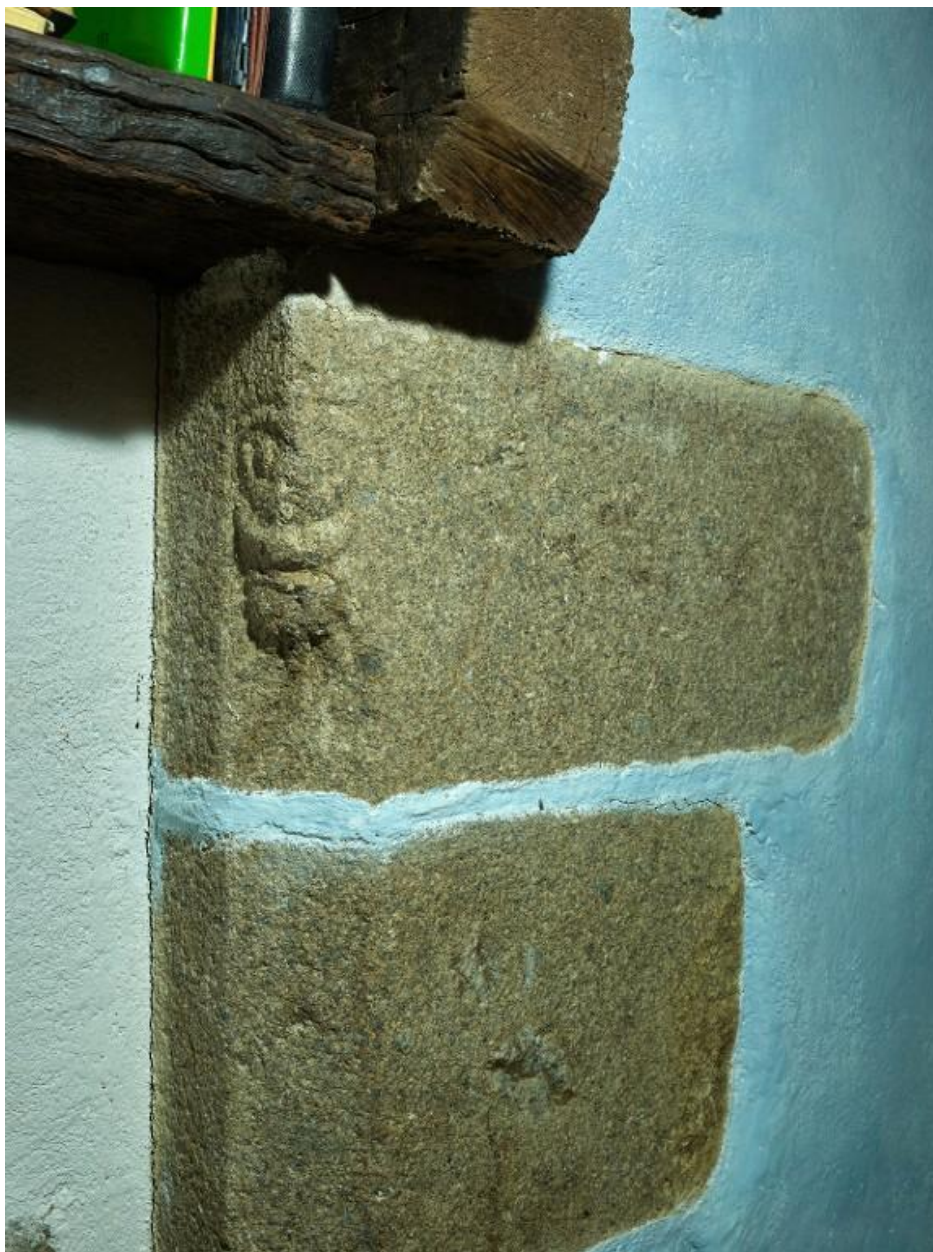
Logis secondaire. Etage. Cheminée sur le mur de refend. Détail d'un jambage avec tête sculptée sur la partie supérieure
