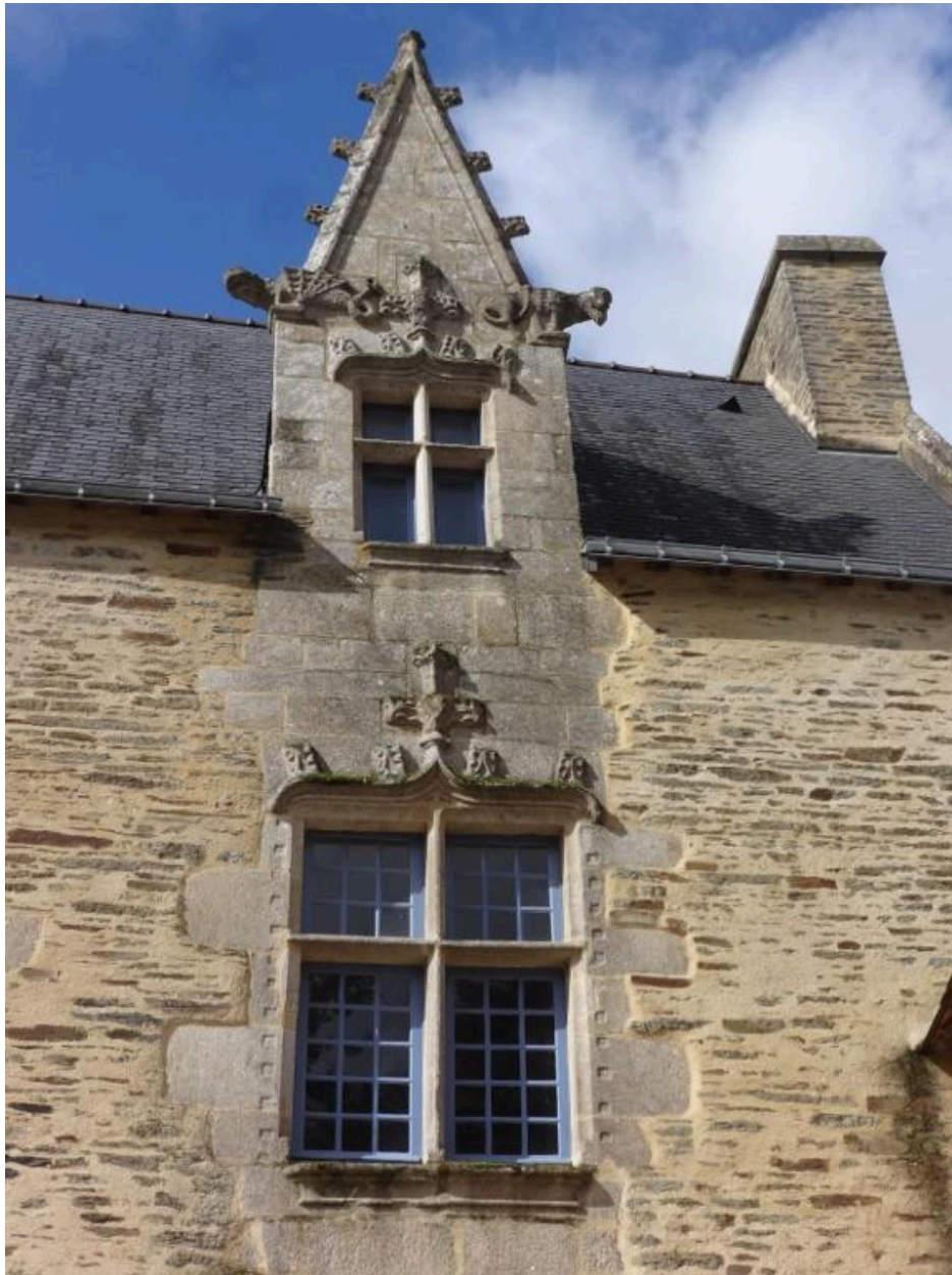
Lucarne et fenêtre d'origine, détail, élévation est
