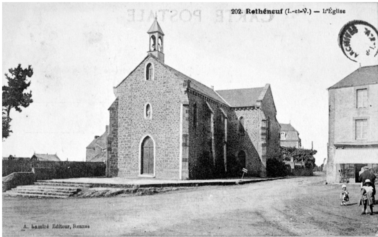
Élévation Ouest : vue générale (Carte postale ancienne, AD35 : 6Fi)
