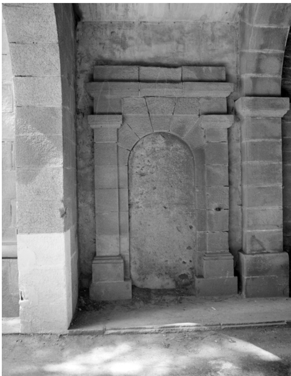
Enceinte de ville - Mur d'enceinte, porte Vauban, détail porte
