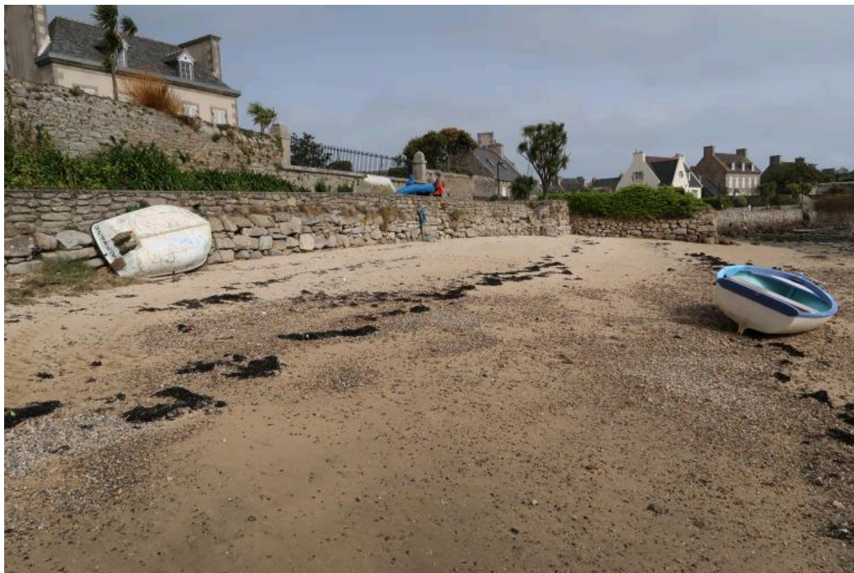
Pors an eog, murs de soutènement et haut de plage
