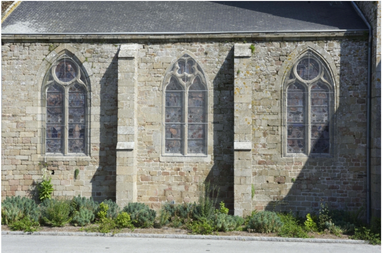
Détail de la façade
