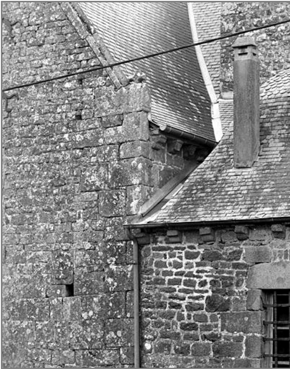
Elévation est : détail de la jonction des toitures avant restauration
