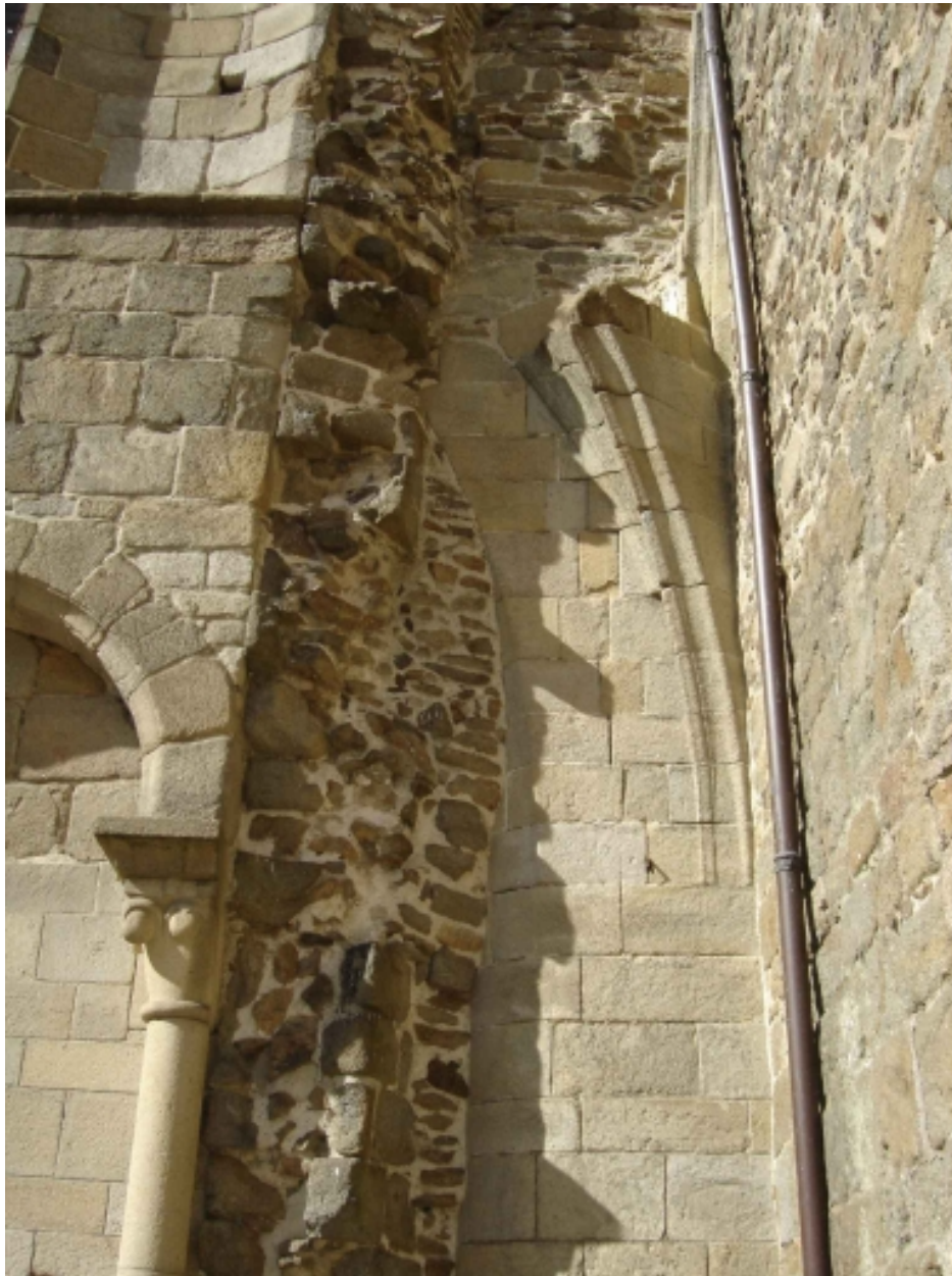
Elévation Sud, extrémité Est
