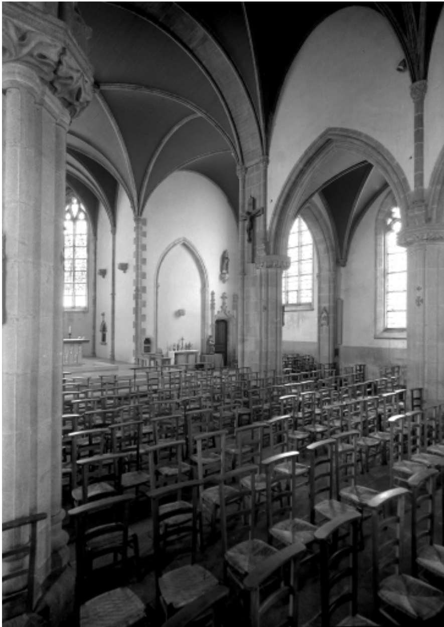
Plonévez-Porzay, église paroissiale Saint-Miliau : nef, vue diagonale, état en 1970
