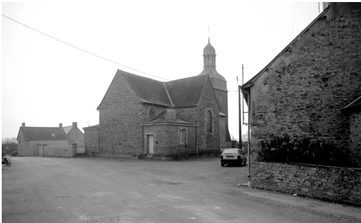
Élévation Nord-Est : vue générale
