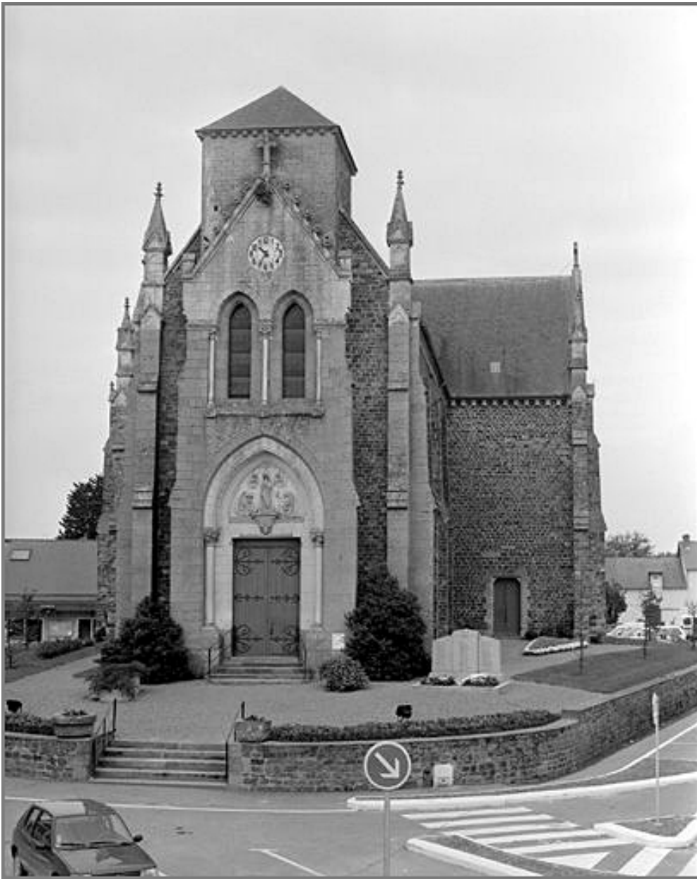
Elévation Est : vue générale
