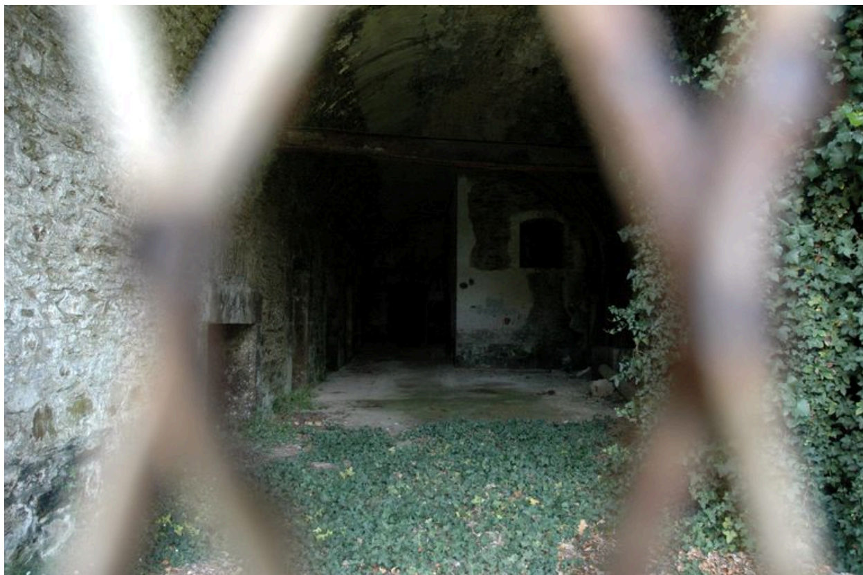
Vue du fort de Penfeld : le couloir central du cavalier
