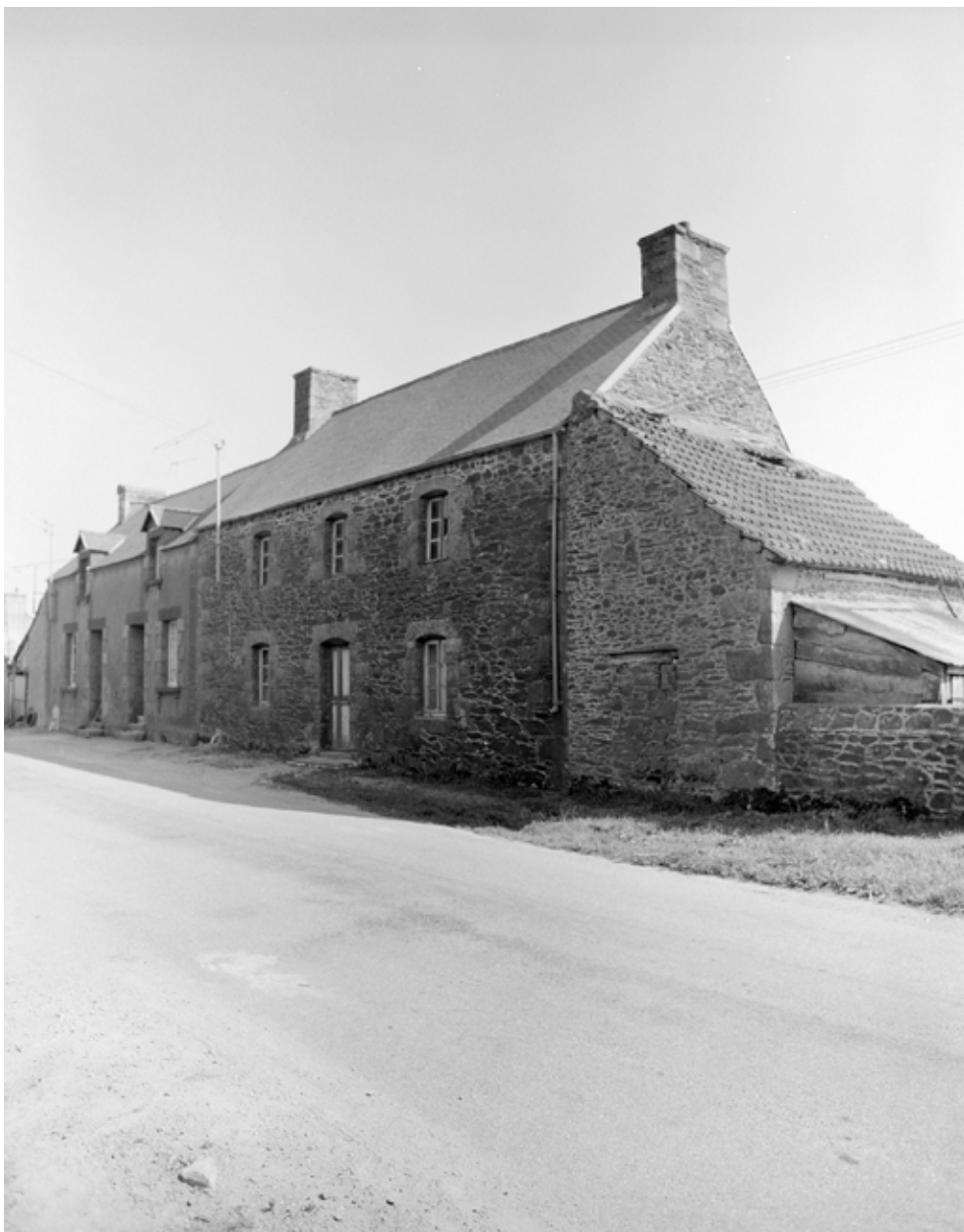
Maison 1 au bourg : vue générale
