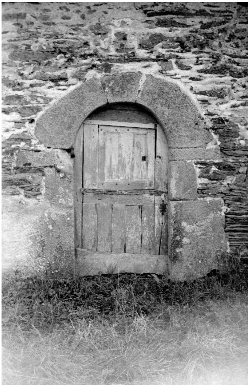
Ferme 5 : la porte (état en 1969)
