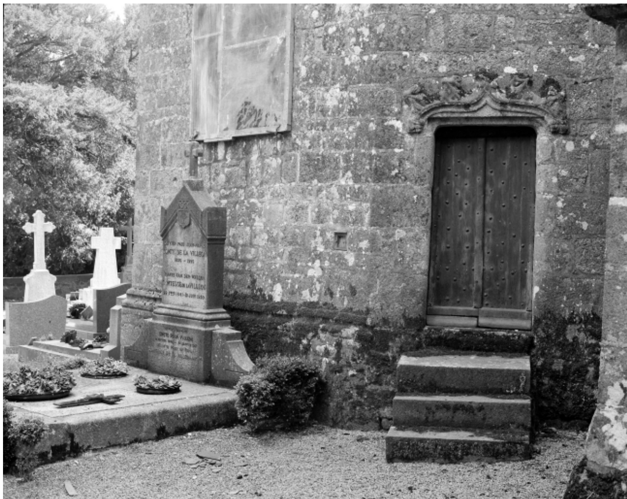
Elévation nord, chapelle de Montmuran : porte, vue générale.
