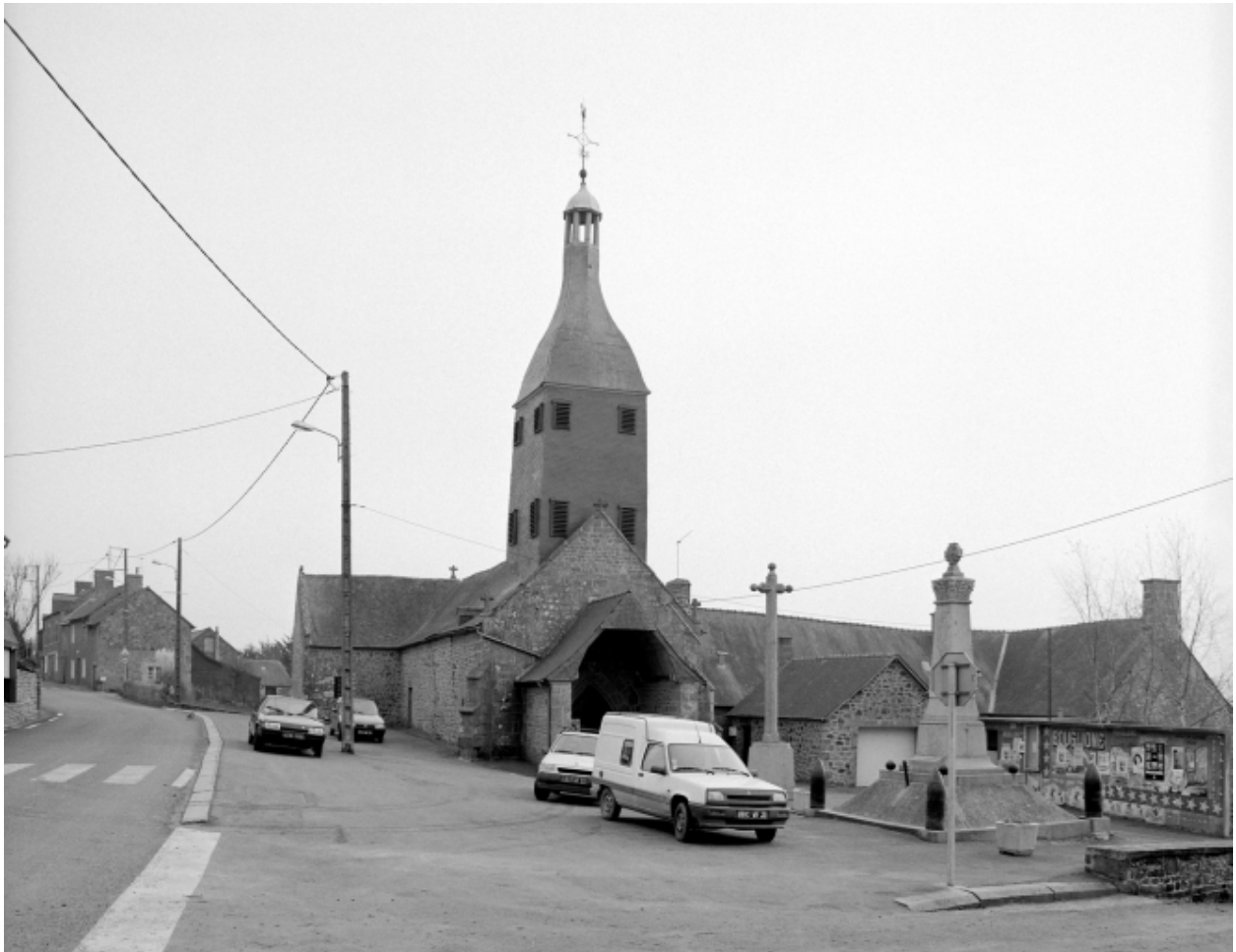
Elévation Sud-Ouest : vue générale
