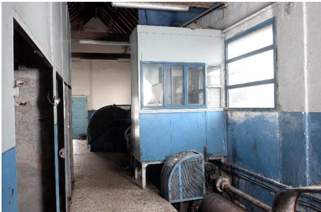
Poste de commande : intérieur du bâtiment
