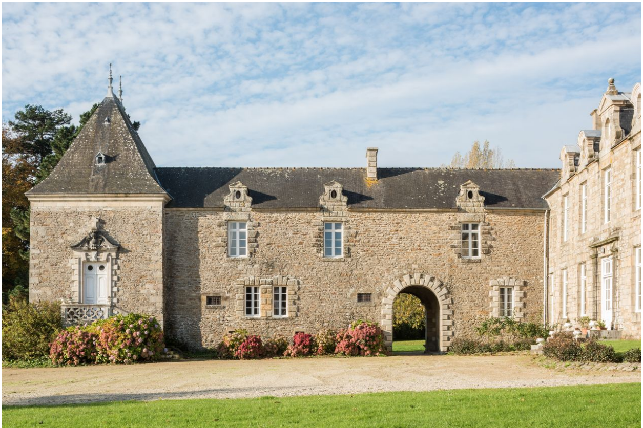
Aile occidentale depuis la cour
