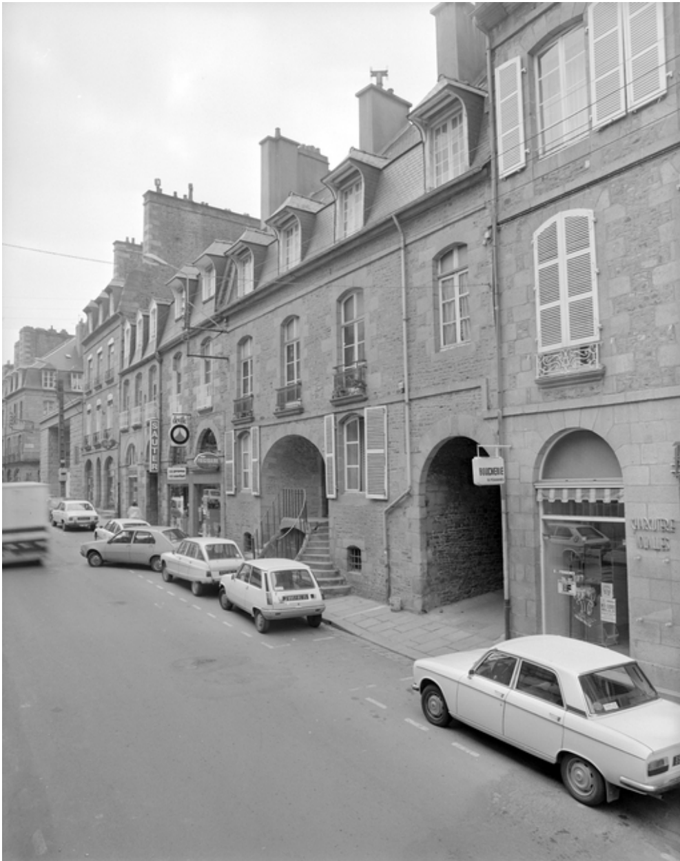
Elévation antérieure, vue générale.
