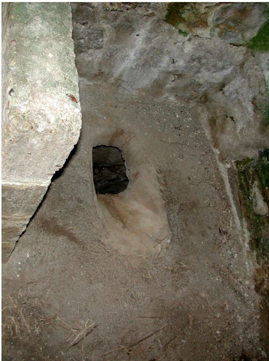
Vue intérieure (état en 2002)
