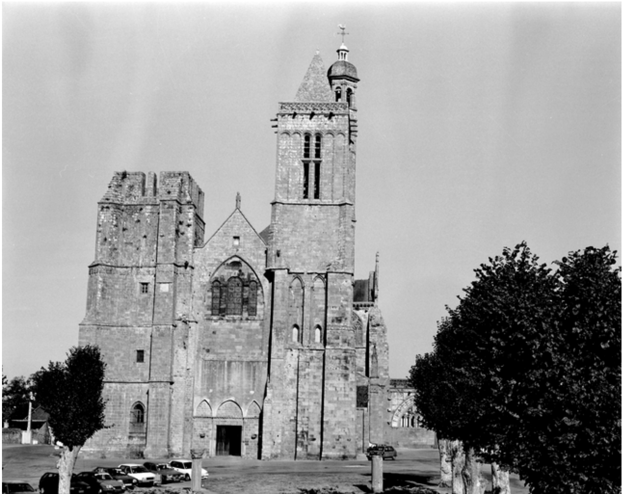
Vue générale ouest
