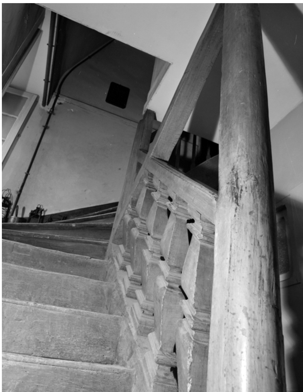
2 rue des Forges, escalier, détail.
