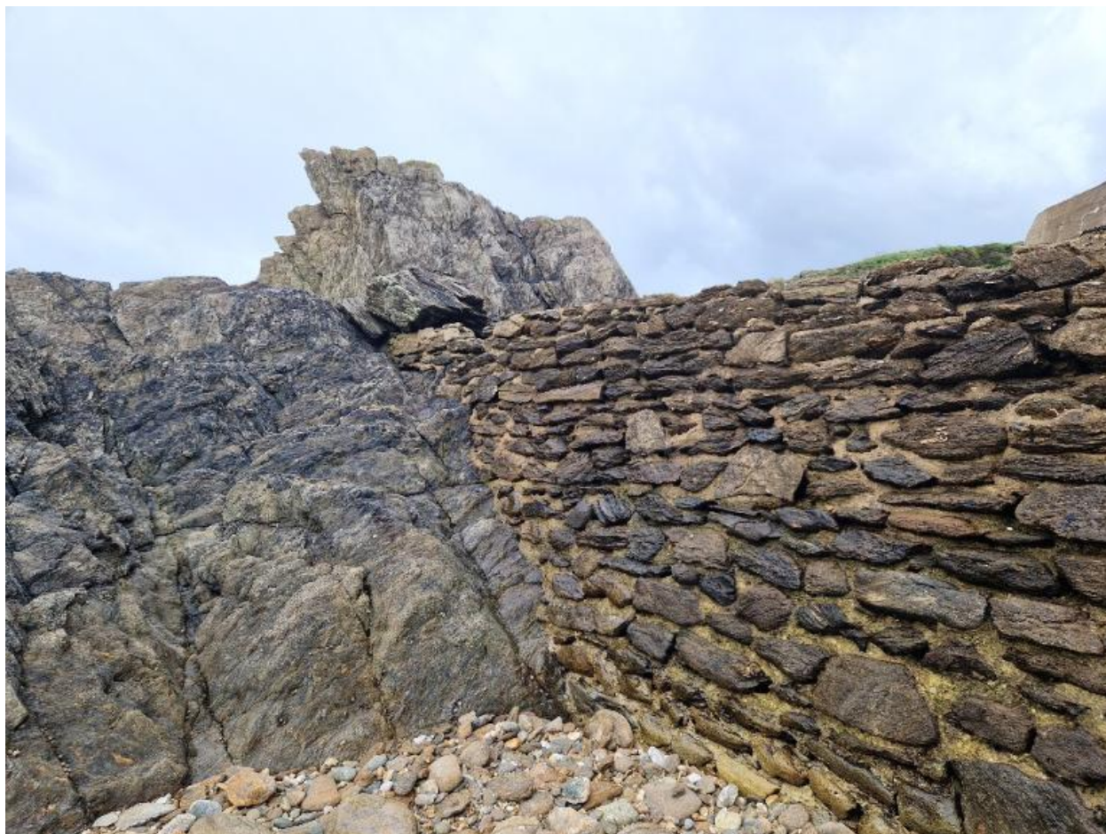
Vue de détail de la maçonnerie de moellon
