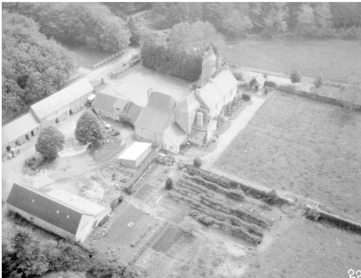
Vue aérienne : vue générale nord-est
