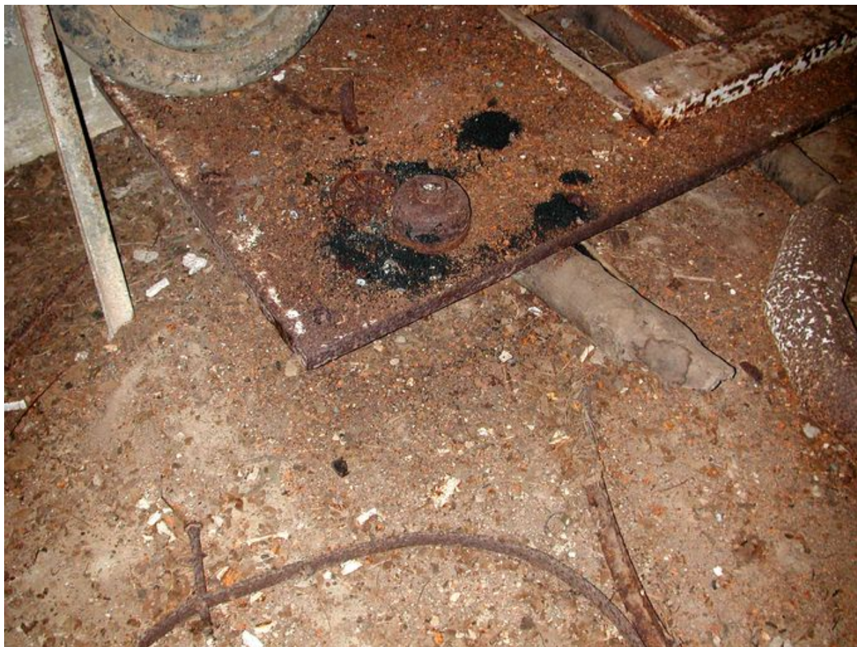
Vue de la chambre de troupe de gauche : cartouche de masque à gaz (état en 2003)
