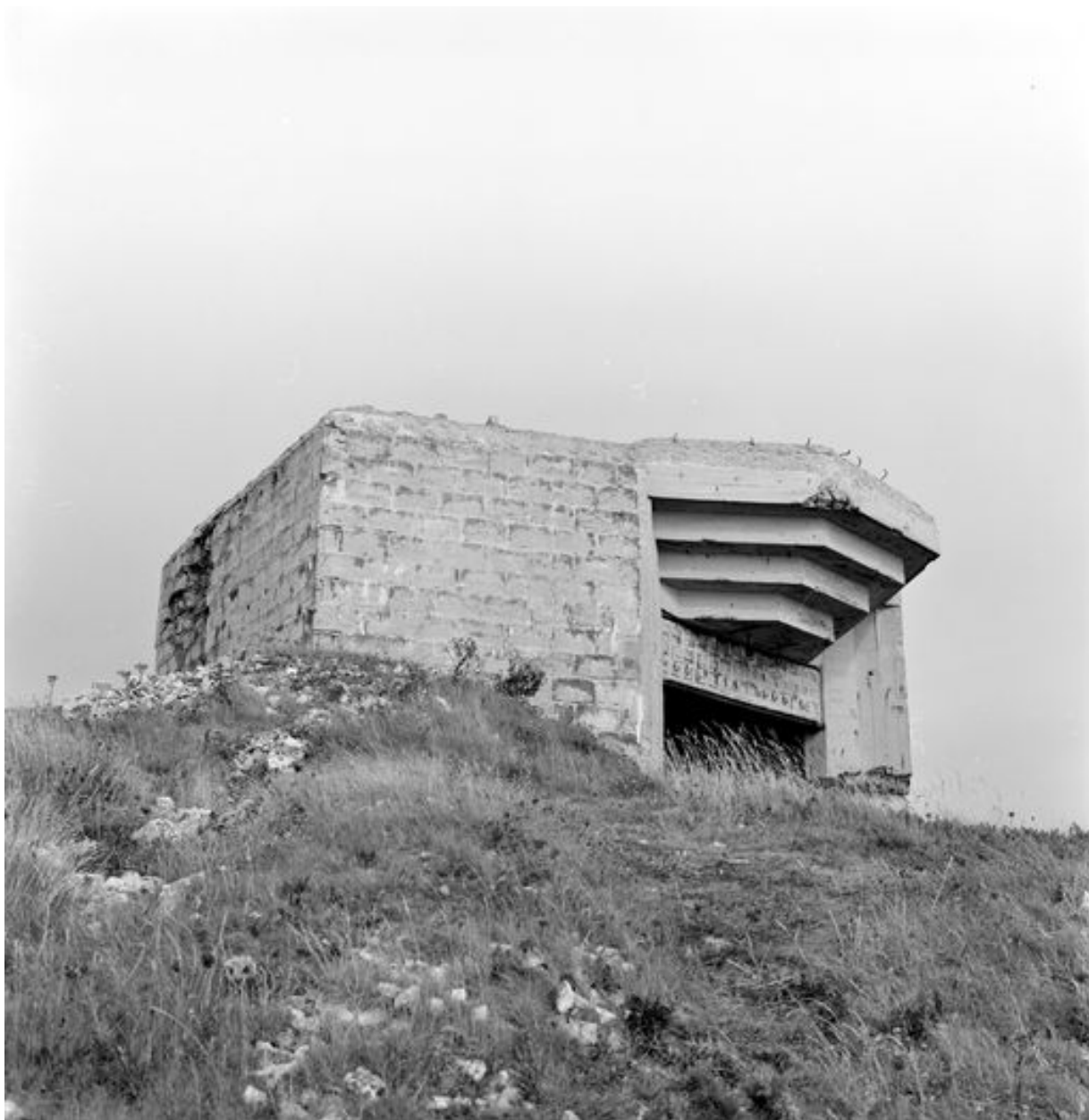
Vue en contre-plongée de l'un des trois bunkers - casemates pour canon de 164,7 mm en 1969 (le quatrième bunker a été détruit en 1944 par une explosion)
