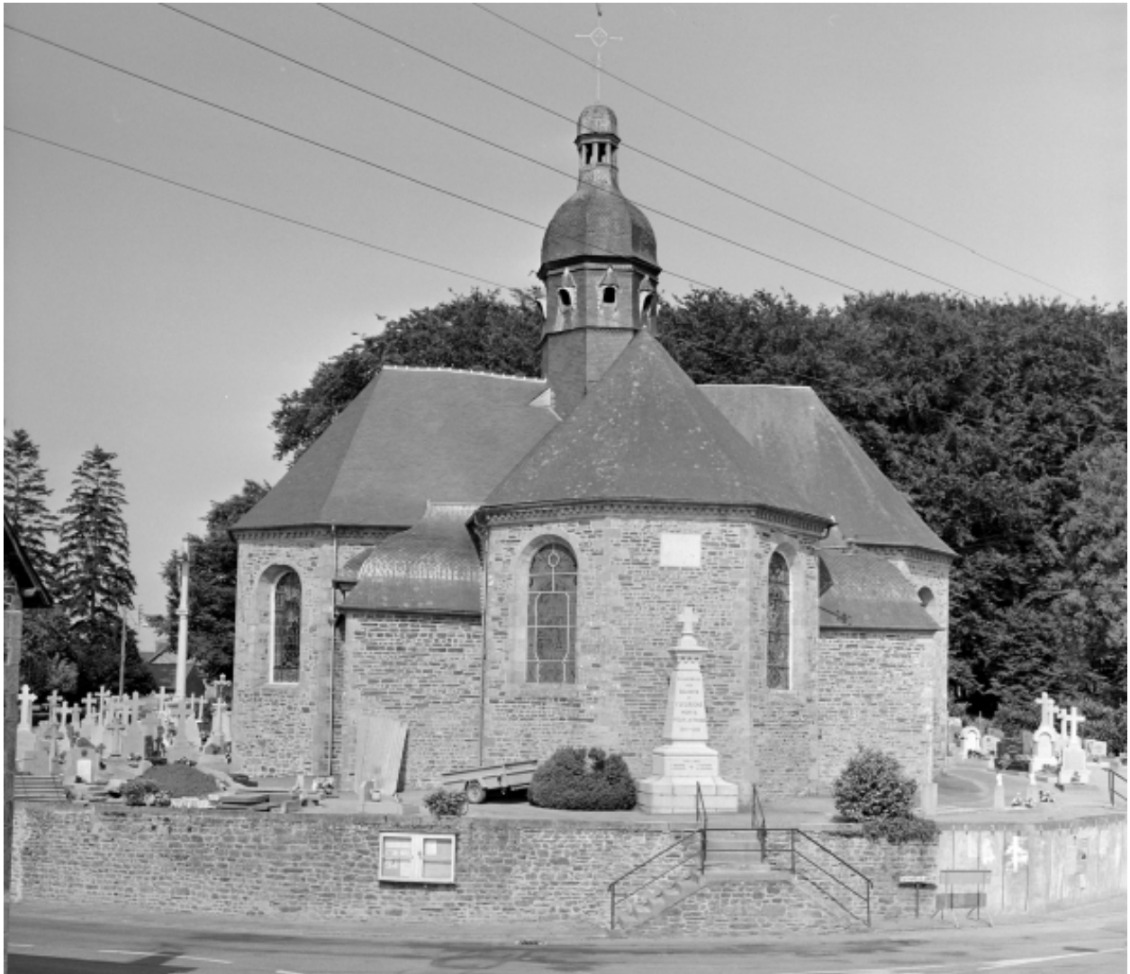
Elévation Est : vue générale
