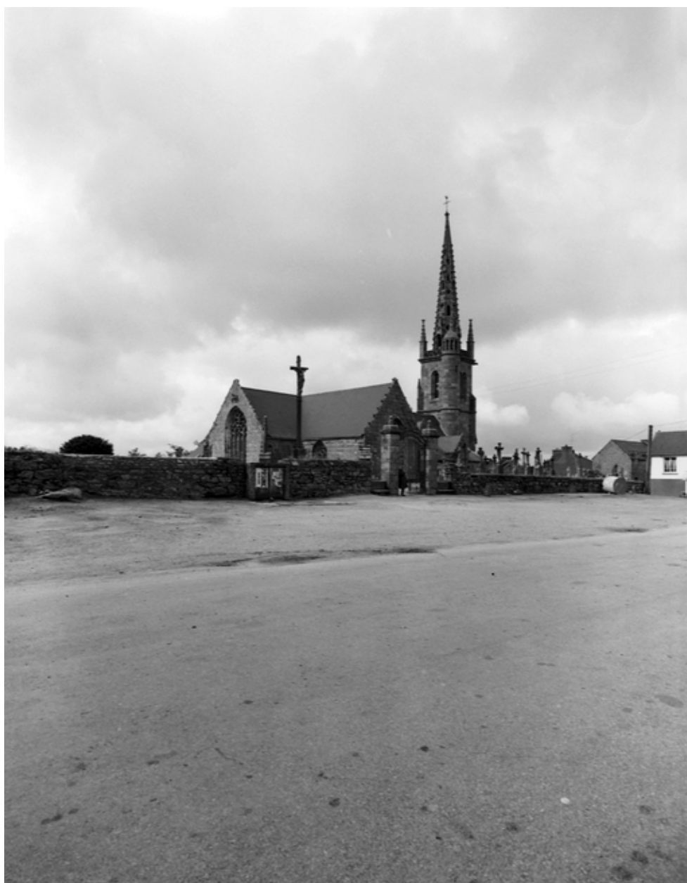
Vue de situation nord-est
