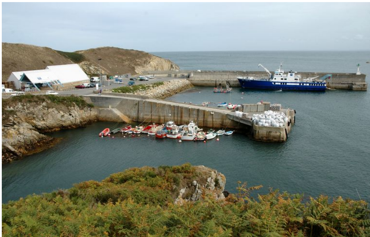
Vue générale du port-abri du Stiff
