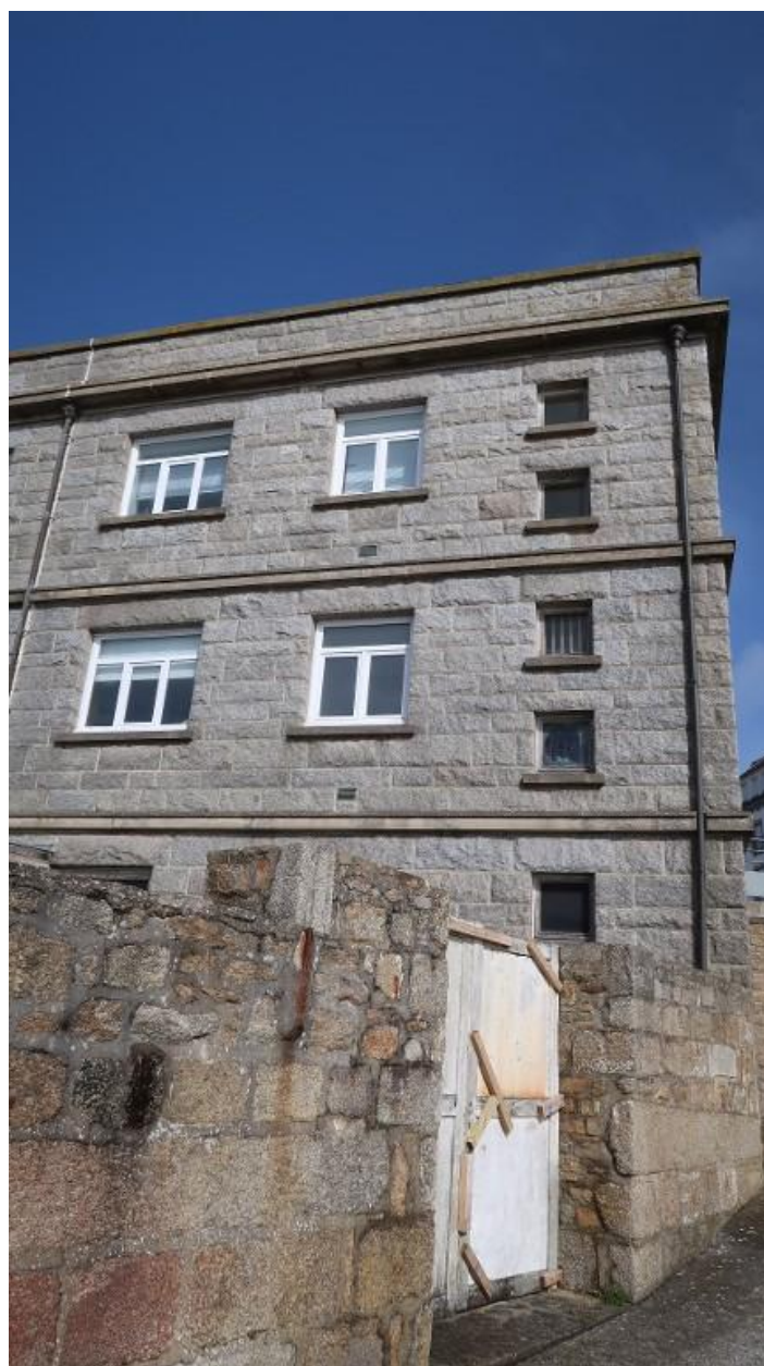
Station biologique, élévation sud
