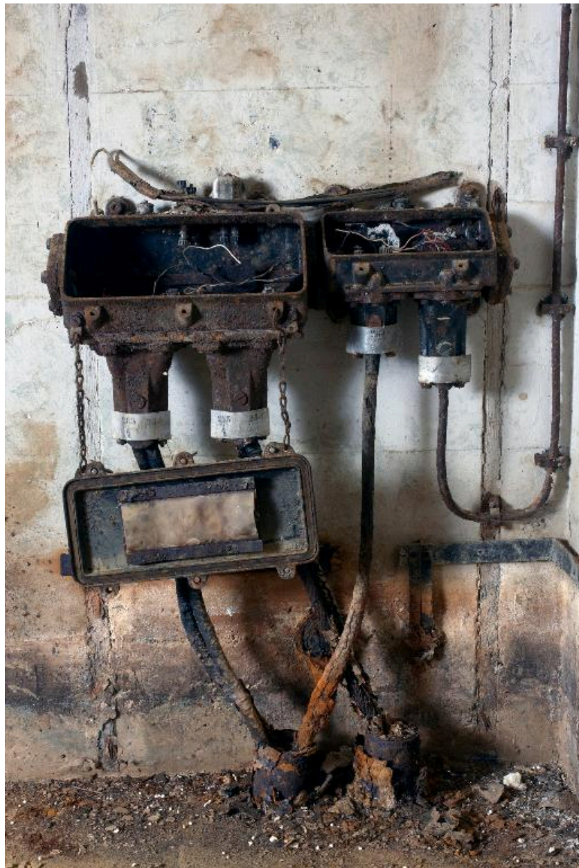
Vue du boîtier de connexion téléphonique : détail (lignes 285, 284, 283), photographie réalisée le 11 mai 2009
