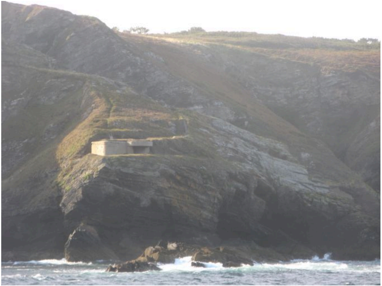
Abri du projecteur de la batterie de Kerviniou
