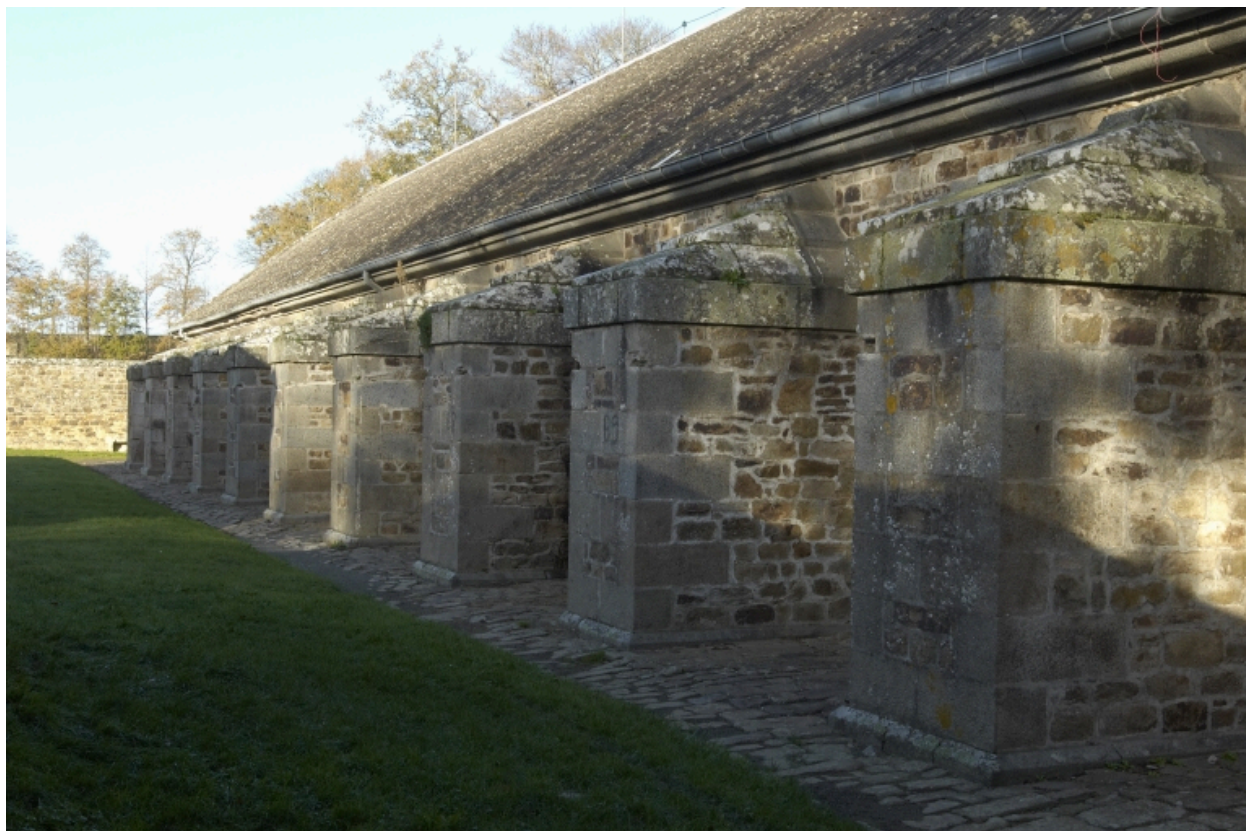
Vue du du magasin à poudre : détail de l'élévation nord avec ses contreforts
