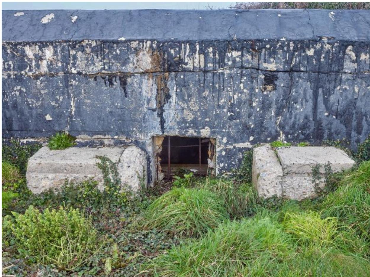
Vue de la sortie de secours de la salle de garde (mur sud-ouest). Le puits en béton de la sortie de secours a été déconstruit lors de la transformation du bunker en logement ; le bunker a été recouvert de goudron
