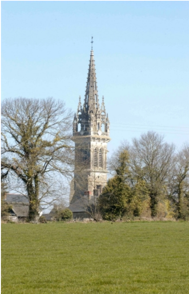
Le clocher dominant le bourg : vue générale sud-ouest
