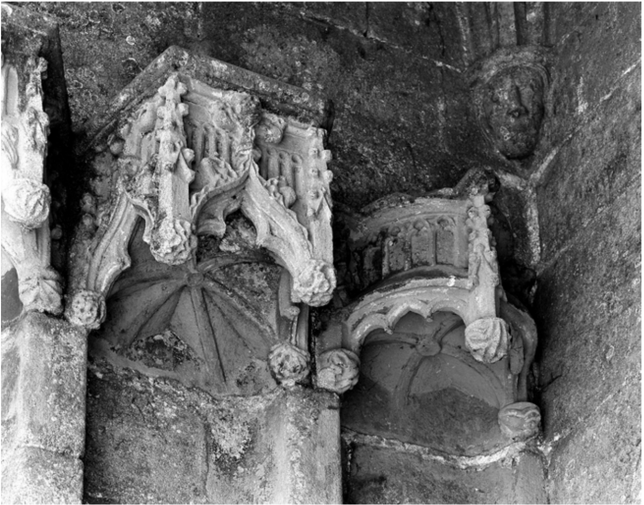
Porche sud, mur ouest, dais des niches nord.
