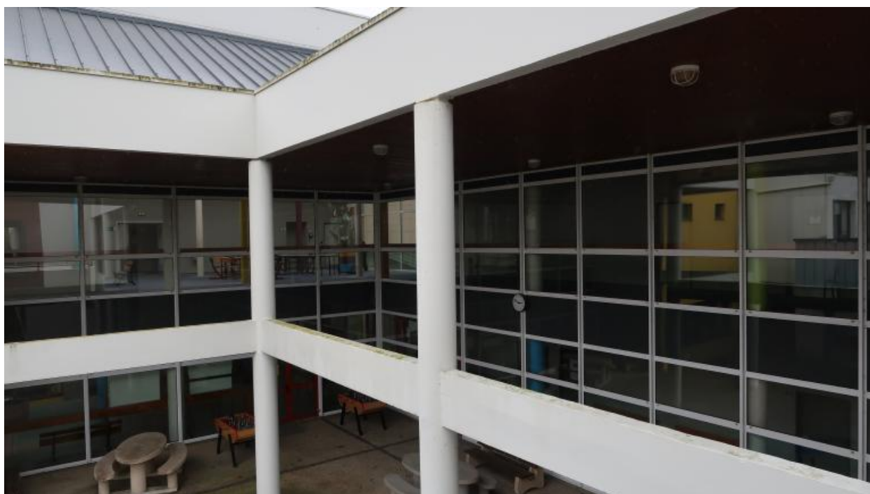
Détail sur le portique du préau.
