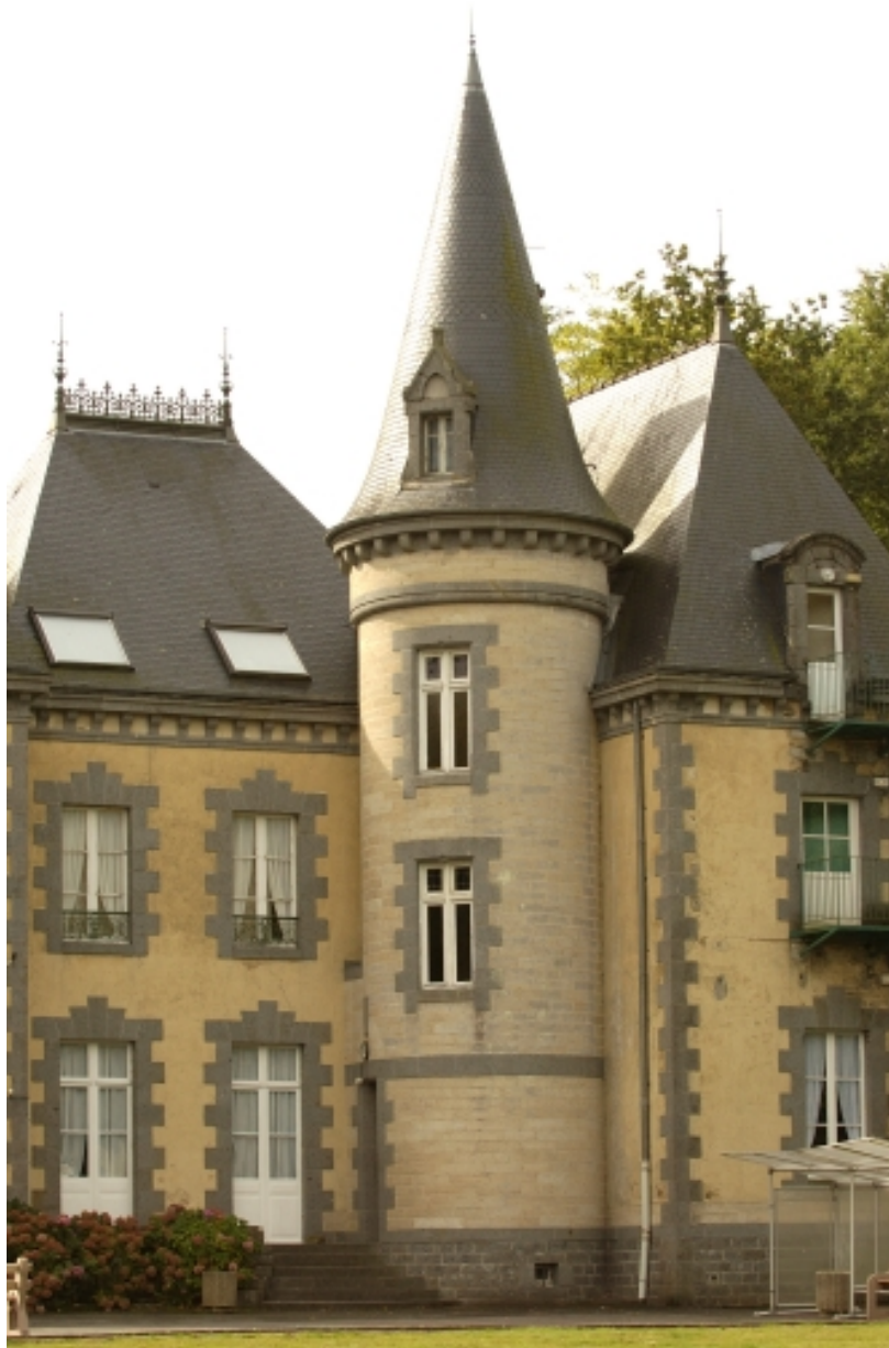
Détail de la tour d'escalier
