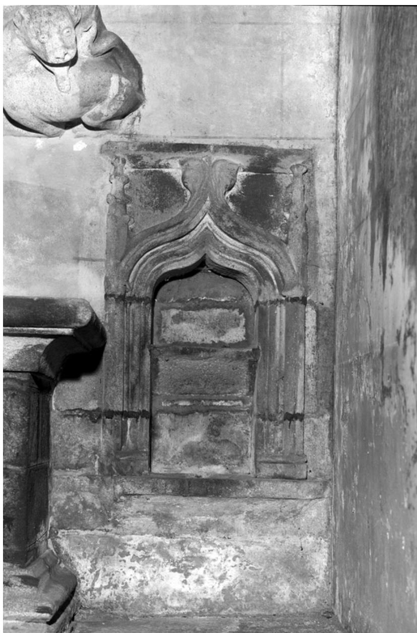
Choeur, mur est : détail de la crédence à droite de l'autel
