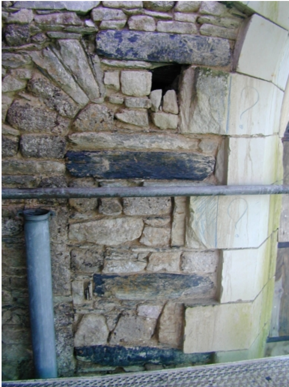
Façade nord, ancienne baie romane murée : détail
