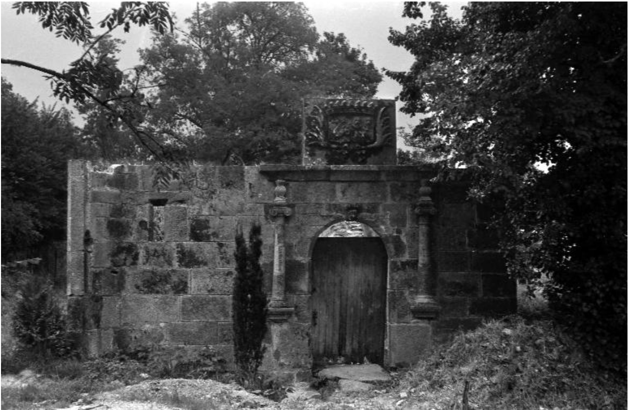
Château de Rosmorduc, ruine ancienne chapelle (état en 1969)
