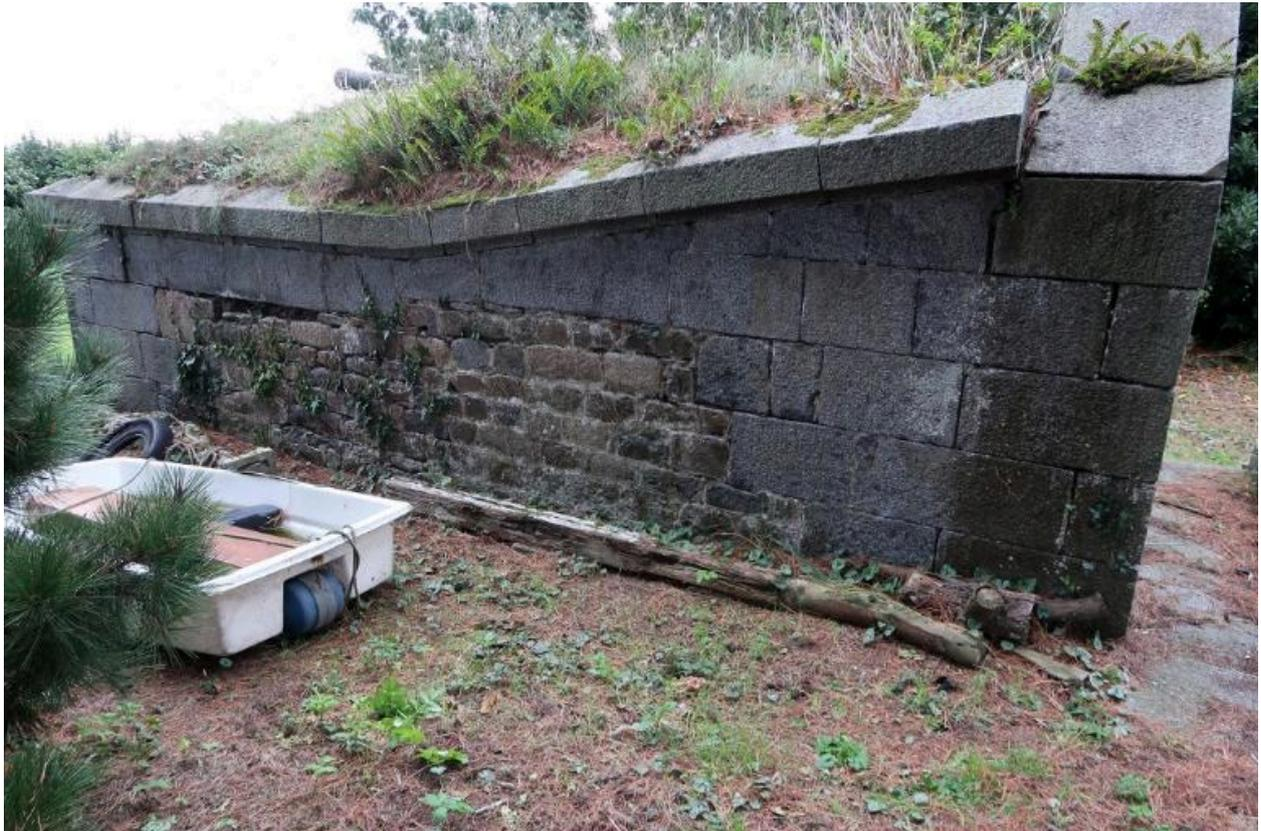
Vue de l'élévation nord en pierre de taille et en maçonnerie de moellon de granite (état en 2024). Une tablette en pierre de taille couronne les murs
