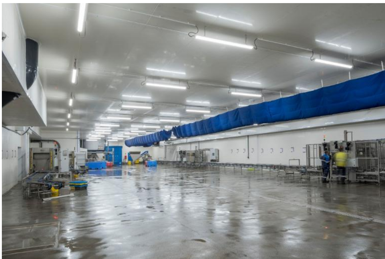
Zone des machines à dépiler les caisses
