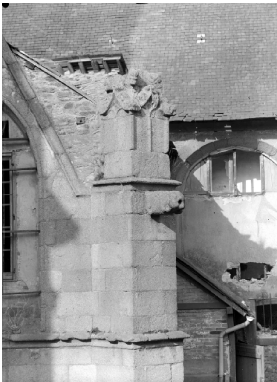
Détail sur un contrefort
