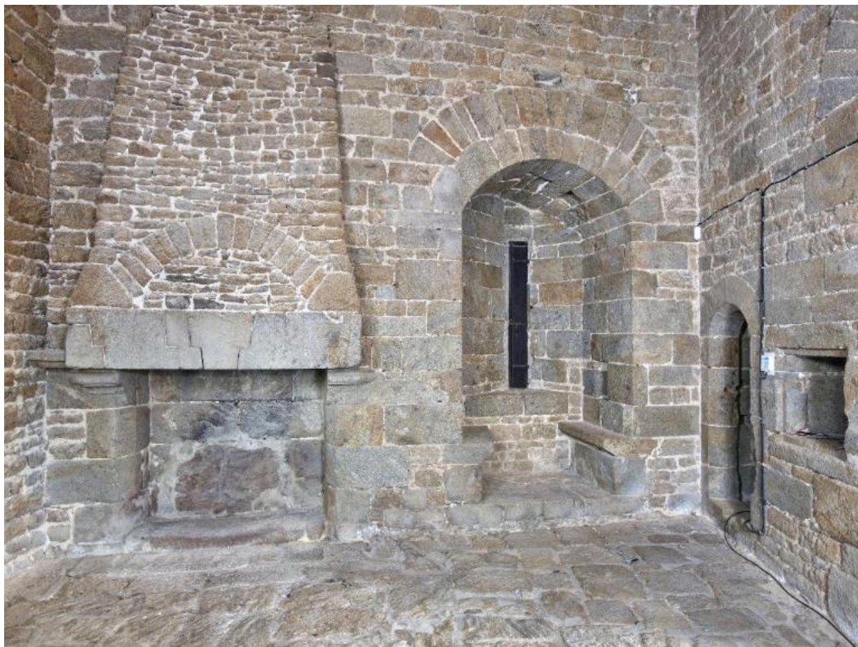
Vue intérieure de la tour Solidor : rez-de-chaussée, pièce intermédiaire, mur nord avec cheminée et arbalétrière-canonnière à double coussiège orientée vers le nord
