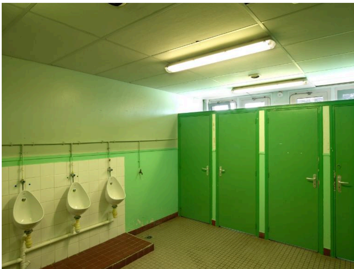
Sanitaires dans l'internat.
